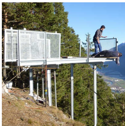
Aufbau vor Ort von Aussichtsplattformen
